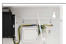
Półka na zasilacz rejestratora, gniazdo 230VAC
